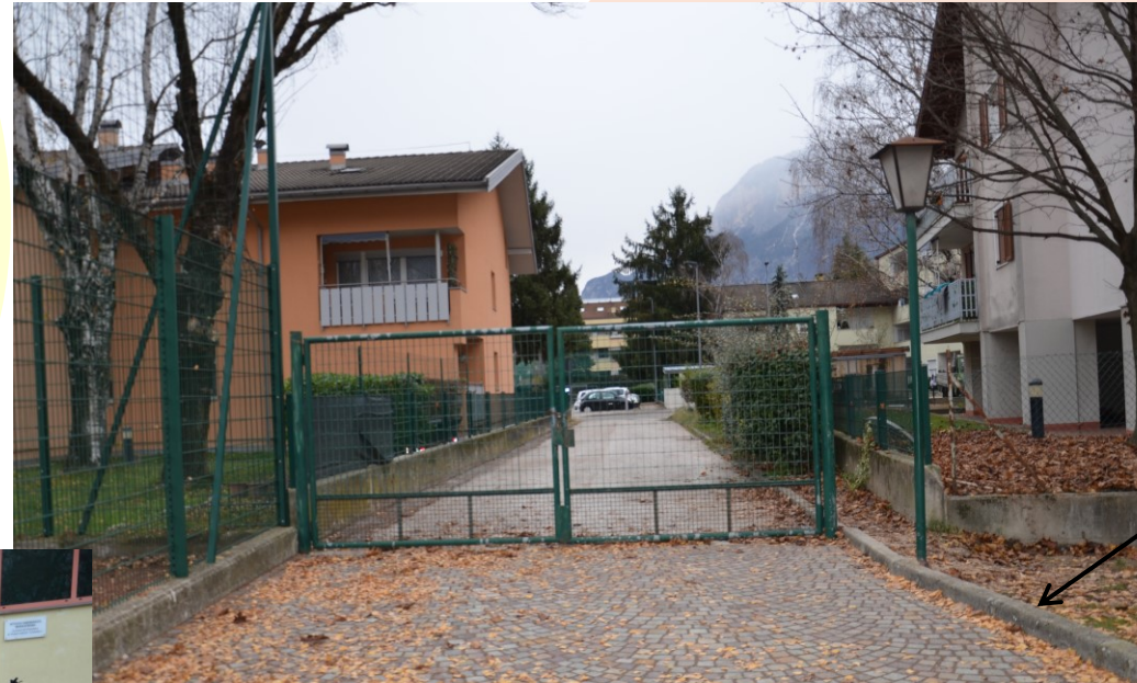
PERCORSO PEDONALE NON ACCESSIBILE DA CHI SI SPOSTA IN SEDIA A ROTELLE A CAUSA DEL BORDO RIALZATO
